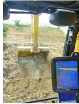
三次元のデータを重機が認識し施工
