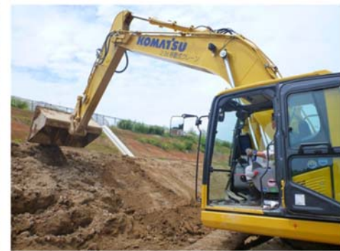
三次元のデータを重機が認識し施工
