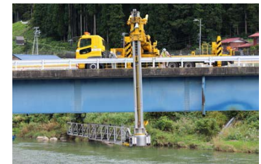
橋梁点検作業
