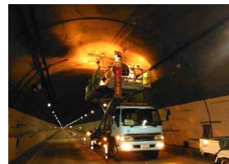
トンネル内ジェットファン撤去設置作業
