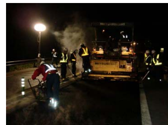
道路修繕作業
