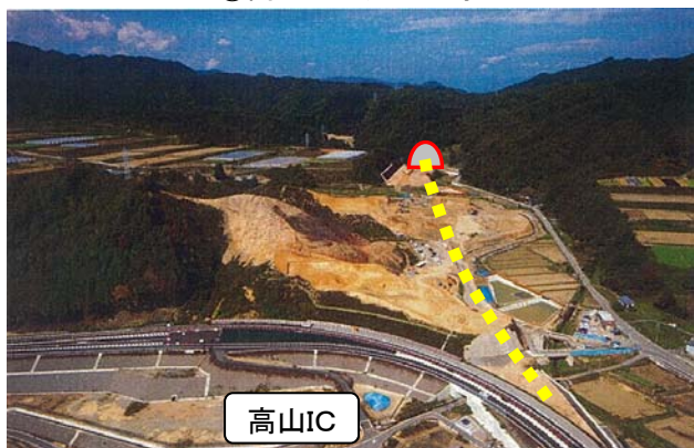
①高山IC付近の工事
