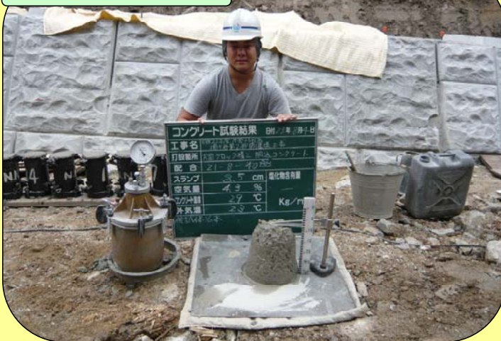
橋ヶ谷第2砂防堰堤工事見学
