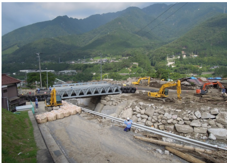
完成した仮橋
