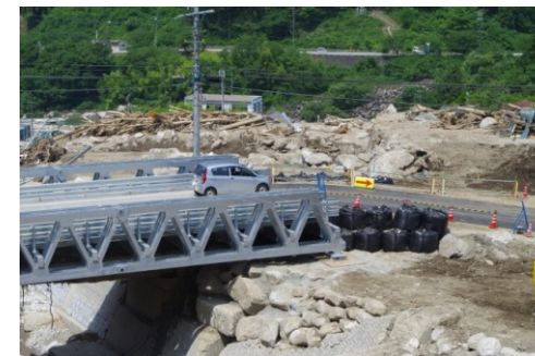
開通した仮橋を通る車両
