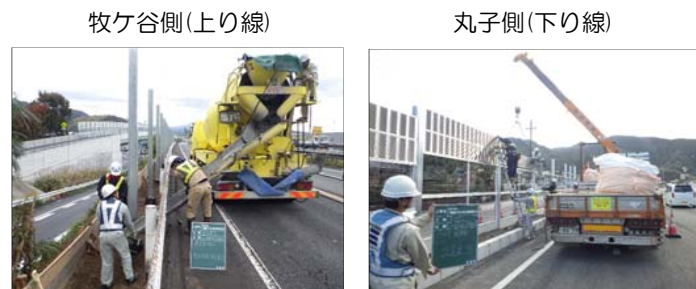
遮音壁設置状況
