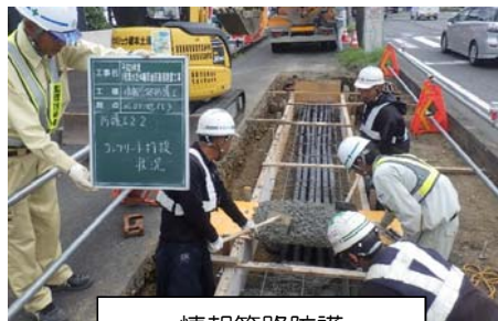
情報管路防護コンクリート打設状況
