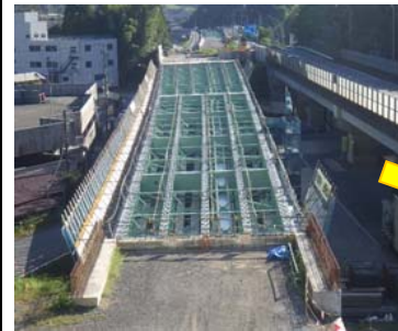
本工事着工前(H29.9月末)
