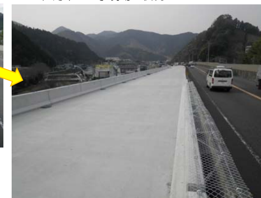
H30.2月末の工事現場の状況
