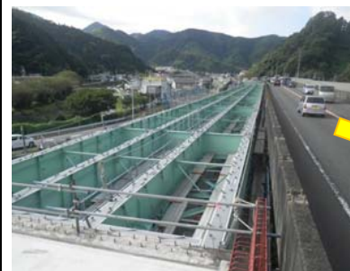
本工事着工前(H29.9月末)
