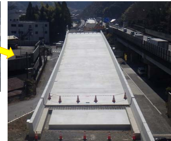
H30.2月末の工事現場の状況
