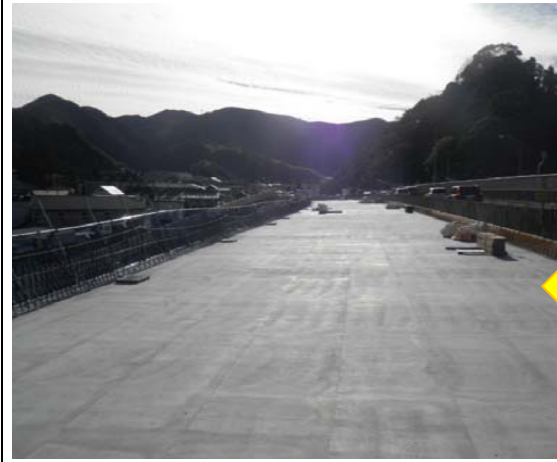
12月末の工事現場の状況
