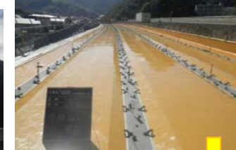
鉄筋組立完了
