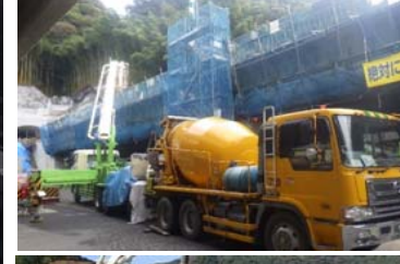
床版コンクリートの打設状況
