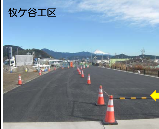
12月末の工事現場の状況
