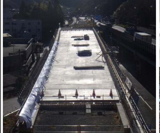
12月末の工事現場の状況
