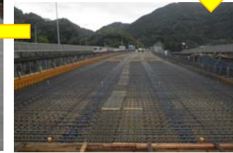
鉄筋組立完了
