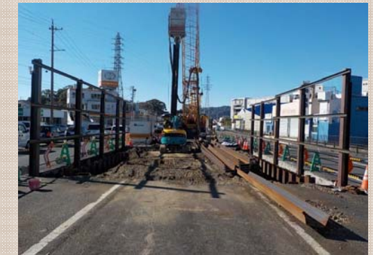
現在、土留用の鋼矢板を打設しています。【12月末現在】
