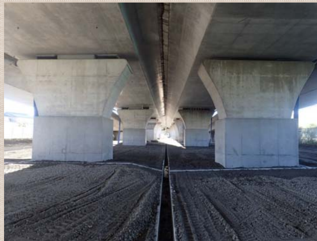
橋脚4基の補強完了しました。
