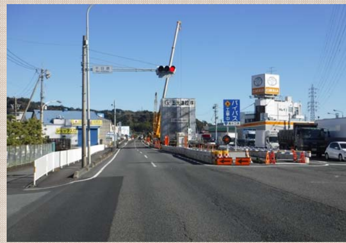
現在、橋脚の柱を造っています。【12月末現在】
