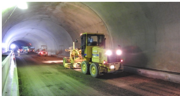
丸子藁科トンネル 上層路盤施工完了(H29.3月末)
