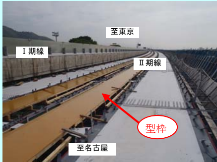
① 鳥坂高架橋
