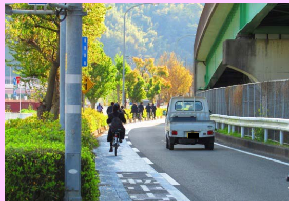
整備後(平成28年4月撮影)
