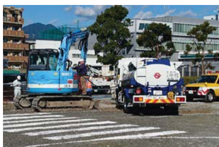
石油商業組合と連携した重機への給油
