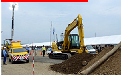
重機によるガレキの撤去
