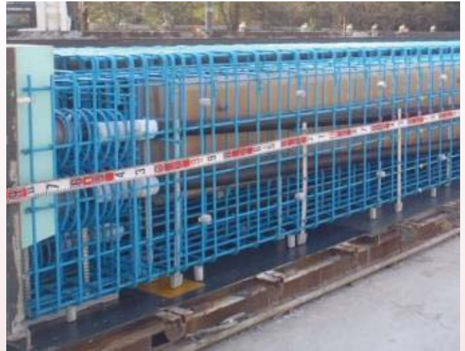
セグメント製作(工場)・エポキシ樹脂塗装鉄筋
