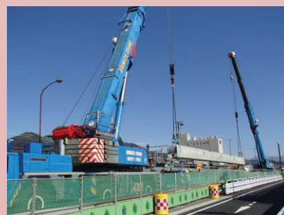
下り線の架設状況
