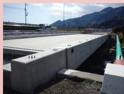
上り線の架設完了
