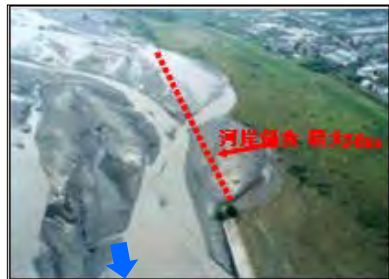
H12.9出水による被災状況(左岸11.75k)
