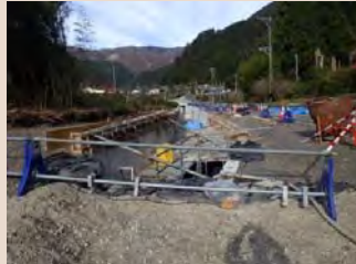
H30年10月末工事状況(起点より)
