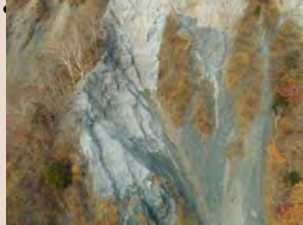
H30年10月末工事箇所状況
