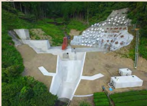
H25年度から施工中の杉の木沢砂防堰堤 (H29年9月末状況)
