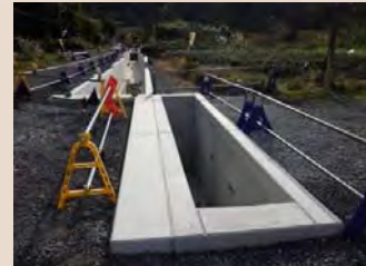
H30年10月末工事状況(終点より)
