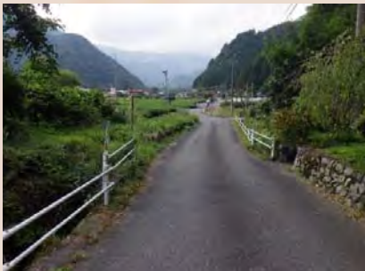
H29年10月末工事着手前状況
