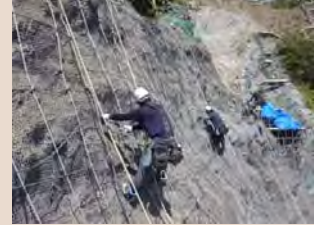
H30年10月末ロープネット設置状況
