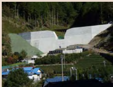
H30年10月末現在、施工状況(下流左岸側よ)
