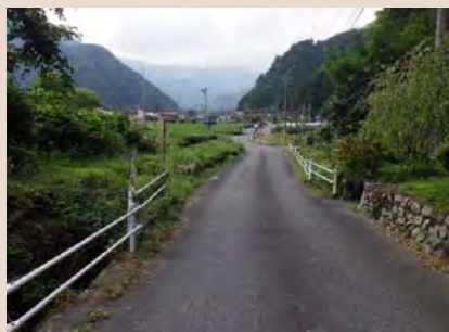
H29年10月末工事着手前状況
