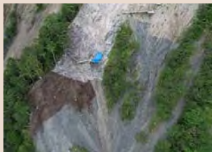
H30年8月末工事予定箇所状況
