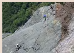
H30年8月末モルタル吹付施工状況
