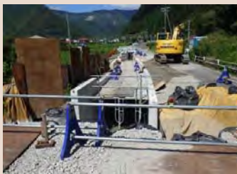
H30年8月末工事状況(起点より)
