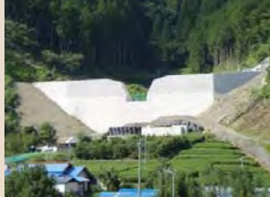
H30年8月末現在、施工状況(下流左岸側より)
