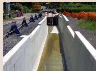
H30年8月末工事状況(終点より)
