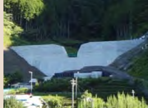
H30年7月末現在、施工状況(下流左岸側より)
