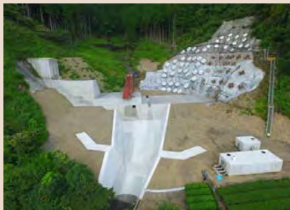
H25年度から施工中の杉の木沢砂防堰堤 (H29年9月末状況)
