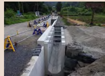
H30年7月末工事状況(終点より)
