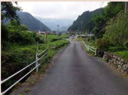
H29年10月末工事着手前状況
