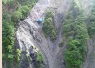
H30年7月末工事予定箇所状況
