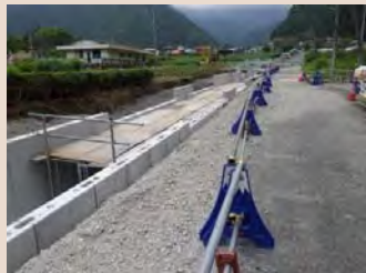
H30年7月末工事状況(起点より)
