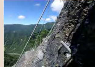
H30年7月末法面アンカー設置完了
