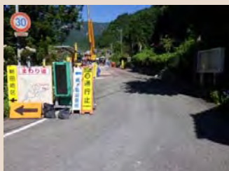
H30年6月末工事状況(起点より)
