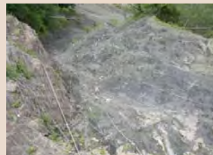
H30年6月末法面清掃完了
