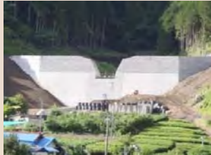
H30年6月末現在、施工状況(下流左岸側より)
