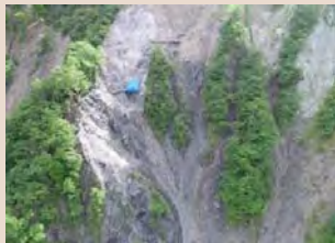
H30年6月末工事予定箇所状況
