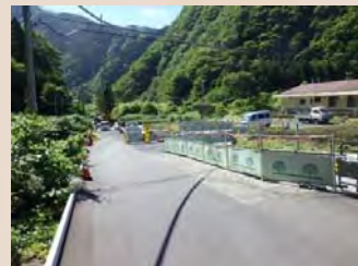
H30年6月末工事状況(終点より)
