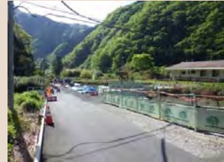
H30年4月末工事状況(終点より)
