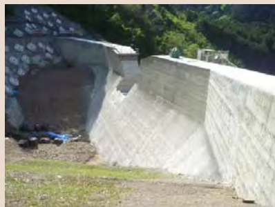
H30年4月末現在、施工状況(上流右岸側より)
