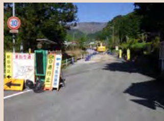
H30年4月末工事状況(起点よ)
