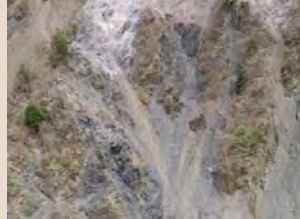
H30年4月末工事予定箇所状況
