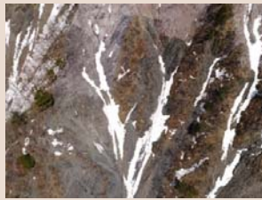
H30年3月末工事予定箇所状況
