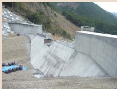
H30年3月末現在、施工状況(上流右岸側より)
