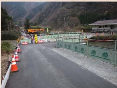
現在、水路を据え付ける作業を行っています。
