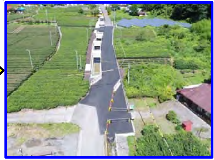
完成(起点から望む)
