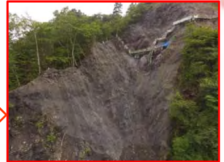
施工状況(亀甲金網張完了)
