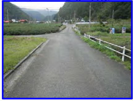
着工前(起点から望む)
