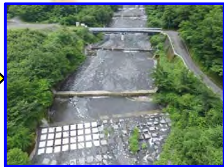
完成(大谷川下流から望む)
