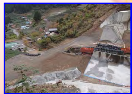
着工前(左岸から望む)
