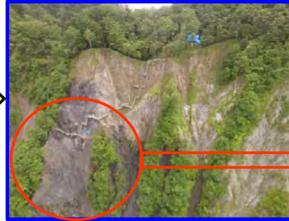
施工状況(7月末時点)
