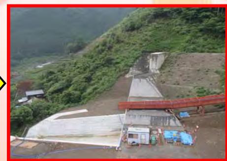
施工状況(7月末時点:左岸から望む)
