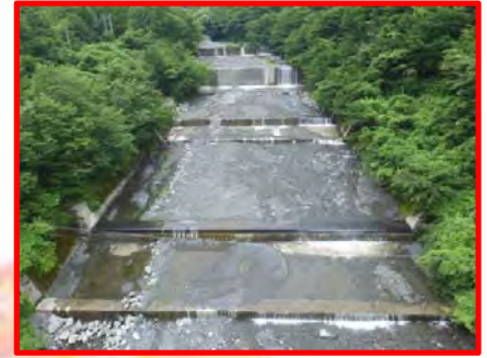
完成(丸山橋から終点を望む)
