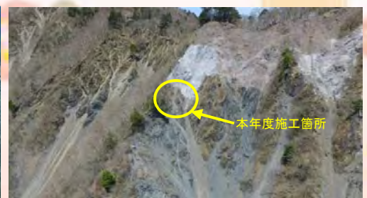
施工箇所は標高約1700m
