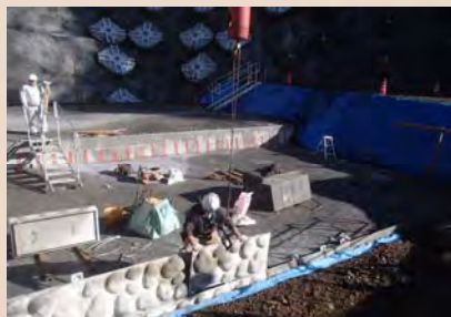
コンクリートパネルの型枠設置状況
