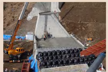
コンクリート打設状況
