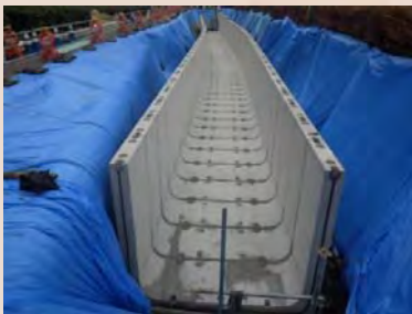
現在、水路を据え付ける作業を行っています。
