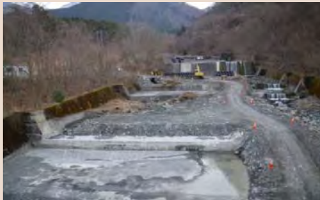
現在、補修箇所の一部取り壊し工事を行っています。
