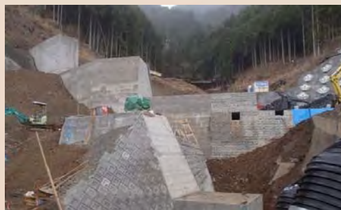
H25年度から施工中の杉の木沢砂防堰堤
