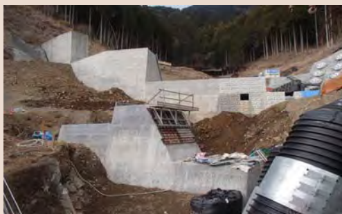
H25年度から施工中の杉の木沢砂防堰堤
