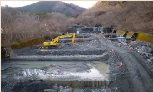
現在、補修箇所の一部取り壊し工事を行っています。
