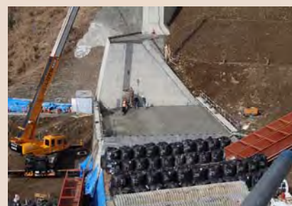
コンクリート打設状況
