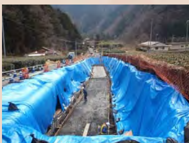
現在、水路を据え付けるための床均し作業を行っています。
