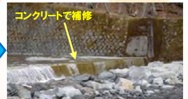
すり減った箇所を補修します(昨年度工事より)
