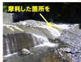
すり減った箇所を補修します(昨年度工事より)
