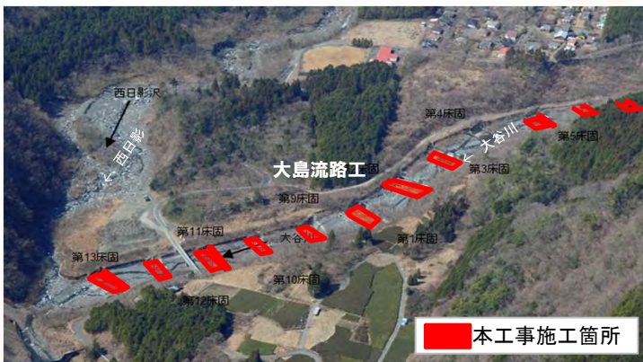
施工後30年以上が経過した大島流路工の補修を行います。
