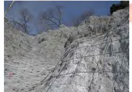
特殊モルタル、ローネットで崩壊拡大を防ぎます。
