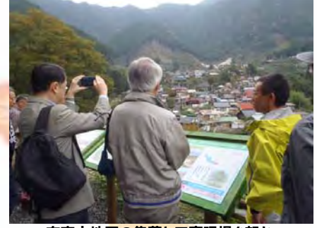
有東木地区の集落と工事現場を望む
