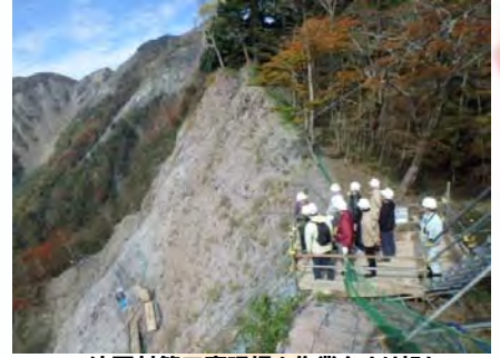
法面对策工事現場を作業台より望む
