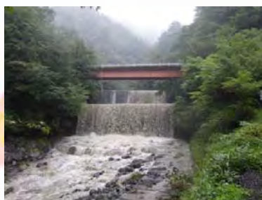
8日14:10 湯の島えん堤の状況
