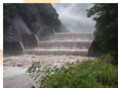
8日15:45 大河内えん堤の状況
