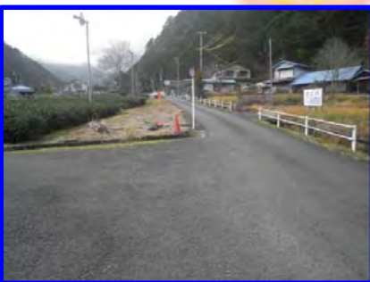
着工前(起点から望む)
