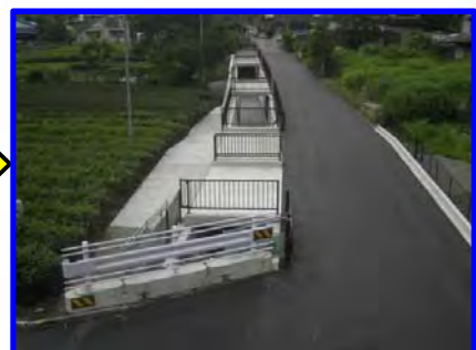
完成(起点から望む)
