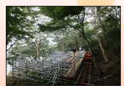
上部モルルール発着所の設置
