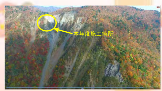
施工箇所は標高約1700m
