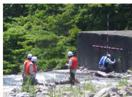
施設点検の様子(孫佐島砂防堰堤)
