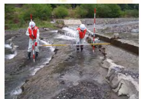
施設点検の様子(三河内川床固工)
