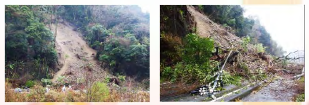
土砂崩れで通行止めとなった県道梅ヶ島昭和線 H27. 3. 1
