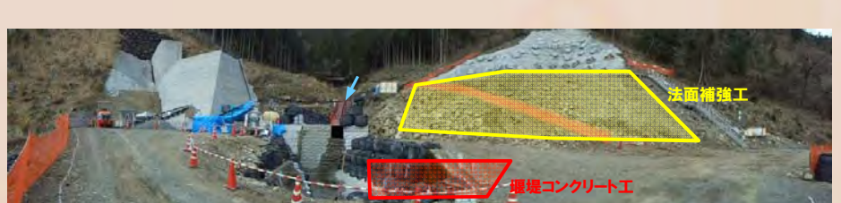
本工事施工箇所
