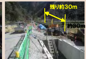
4月以降残り約30mを施工します
