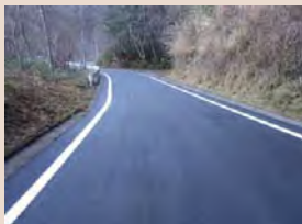
工事用道路の補修
