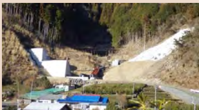
H25年度から施工中の杉の木沢砂防堰堤
