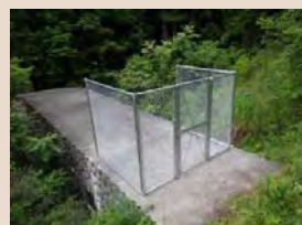
安全施設の補修
