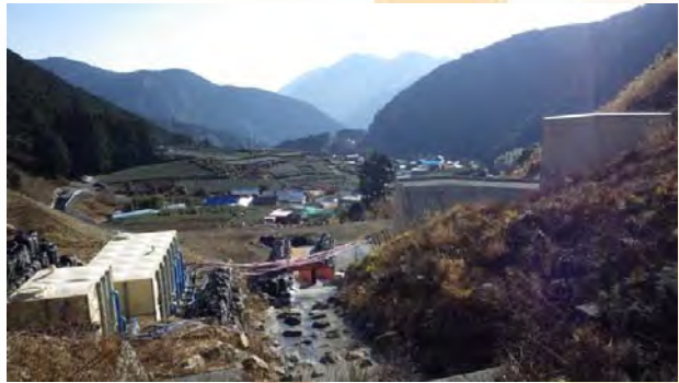
施工現場より下流を望む
