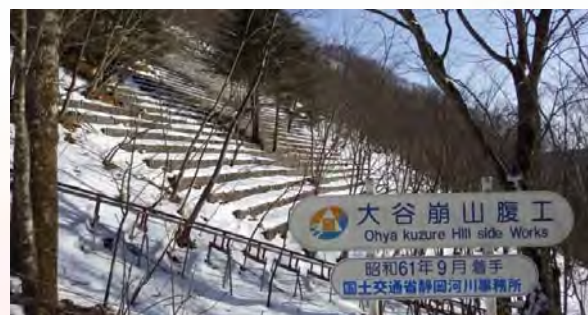
雪に覆われる大谷棚柵工
