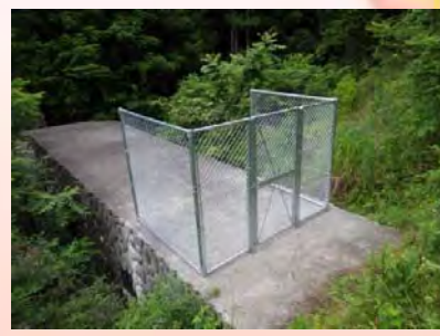
中尾沢砂防堰堤の立入防止柵
