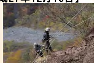
命綱を頼りに特殊モルタル施工
