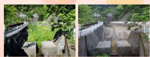
カニ沢砂防堰堤の堆積土除去
