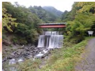
湯の島砂防えん堤
