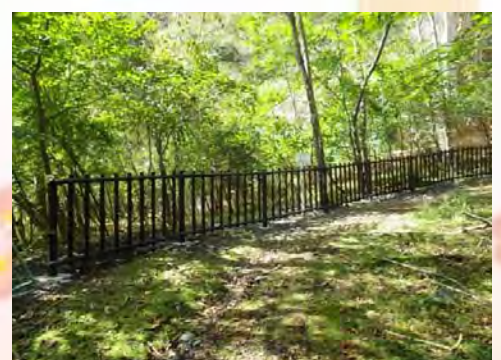
本谷砂防堰堤(扇の要)の立入防止柵
