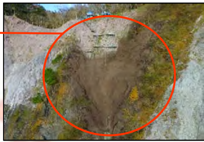
本年度施工箇所
