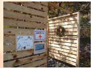
女性用トイレの設置
