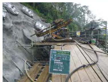
左岸法面工事
