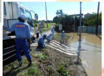
大和橋付近での排水作業状況(9/11)
