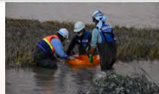
ロードパーク付近での排水作業状況(9/14)
