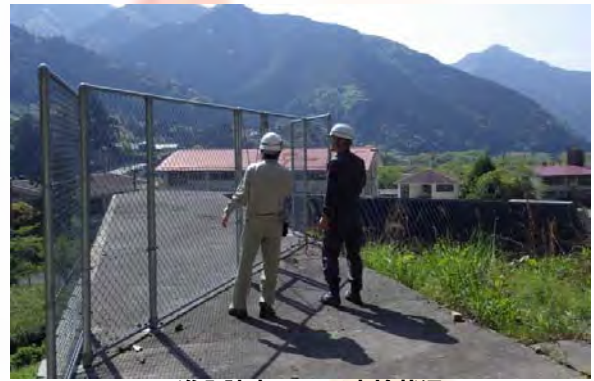
進入防止フェンス点検状況
