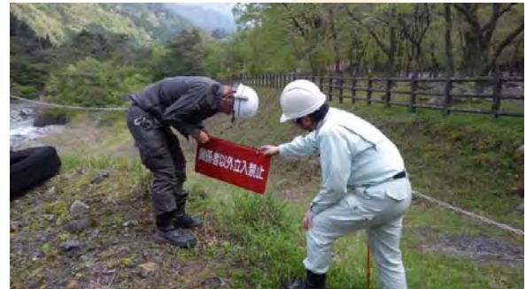
注意喚起看板補修状況
