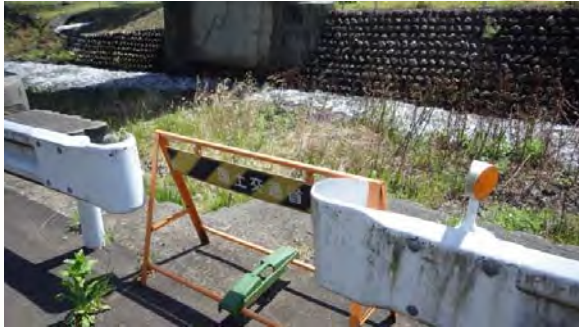
開口部のバリケード設置状況
