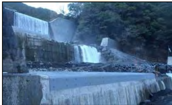
厚さ5cmのゴム製ラバースチール半分設置完了
