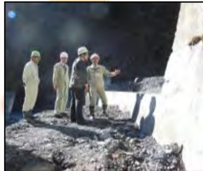
大河内堰堤の損傷を取材
