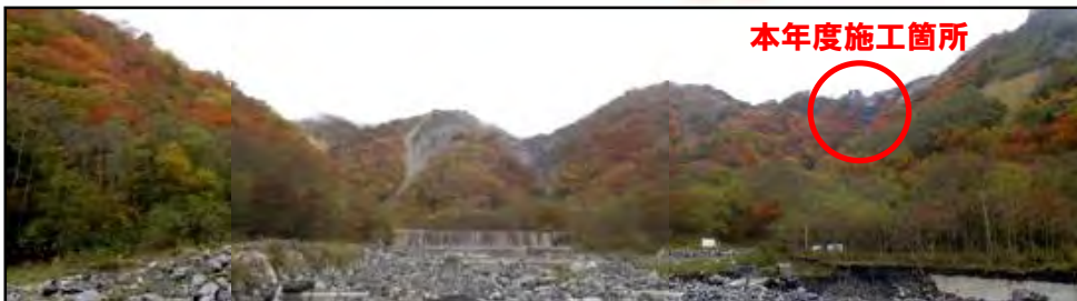
紅葉最盛期の大谷崩(10月26日)と本年度の施工箇所
