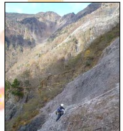
過酷な現場での作業風景
