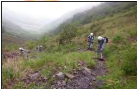
登山道の整備作業状況
