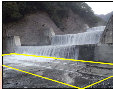
大河内堰堤(90t護床ブロック)
