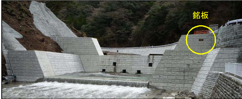
完成した八重沢川砂防堰堤
