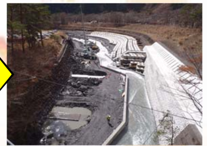
完成間近の大ザレ(吊橋下流)
