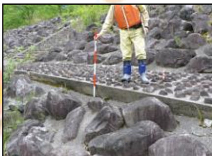
大ザレ巨石護岸の沈下状況
