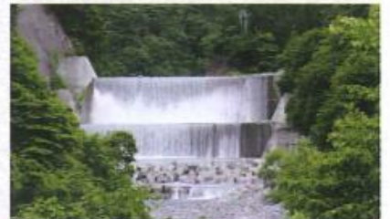
大河内砂防堰堤(S26.3完成)
