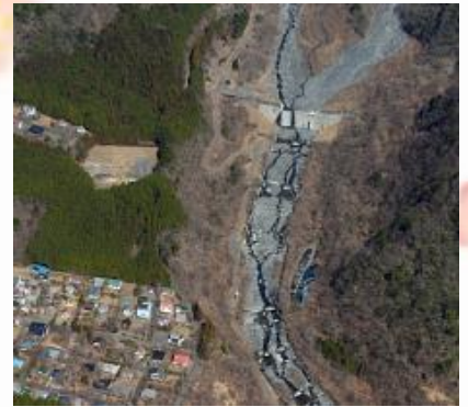
大島砂防堰堤、大島流路工
