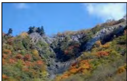
大谷崩の山腹工事現場付近
