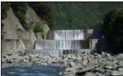
大河内砂防堰堤
