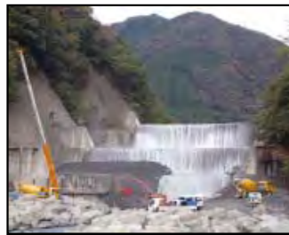
現在の施工状況遠景
