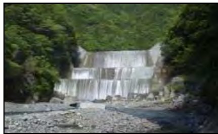
金山砂防堰堤
