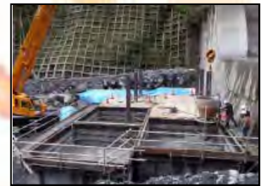
大型護床ブロック施工状況
