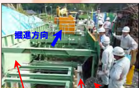
②OSJ機後方部の設置水路と埋戻し状況
