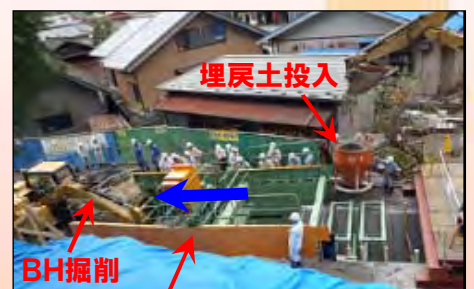
④OSJ工法による施工状況全景
