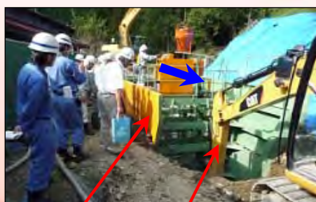
③OSJ機前方部のBH掘削と掘進状況
