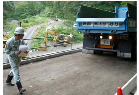
八重沢川砂防堰堤工事の付替道路ブルフロー（下層路盤）段階確認状況
