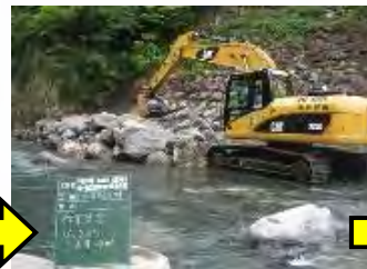
(写真2)袋詰玉石を空洞部に (写真3)重機にて巨石を並べる (写真4)完成状況(全景)
