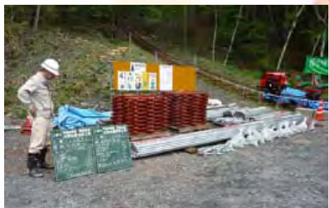
大谷崩にてモノレールの材料検査状況
