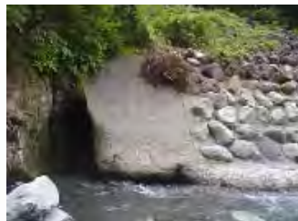
(写真1)被災状況
